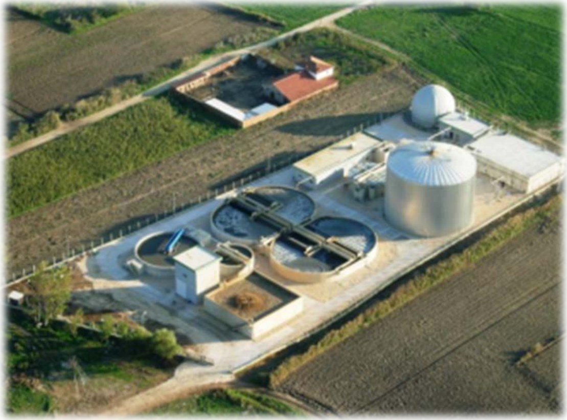
Şekil 3.2. Süttaş Süt Ürünleri Arıtma Tesisinin genel görünümü
