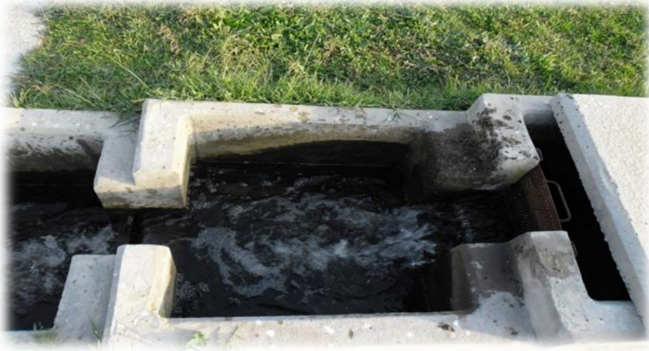
Şekil 3.7. Bursa Batı Atıksu Arıtma Tesisi Deşarj noktasının görünümü
