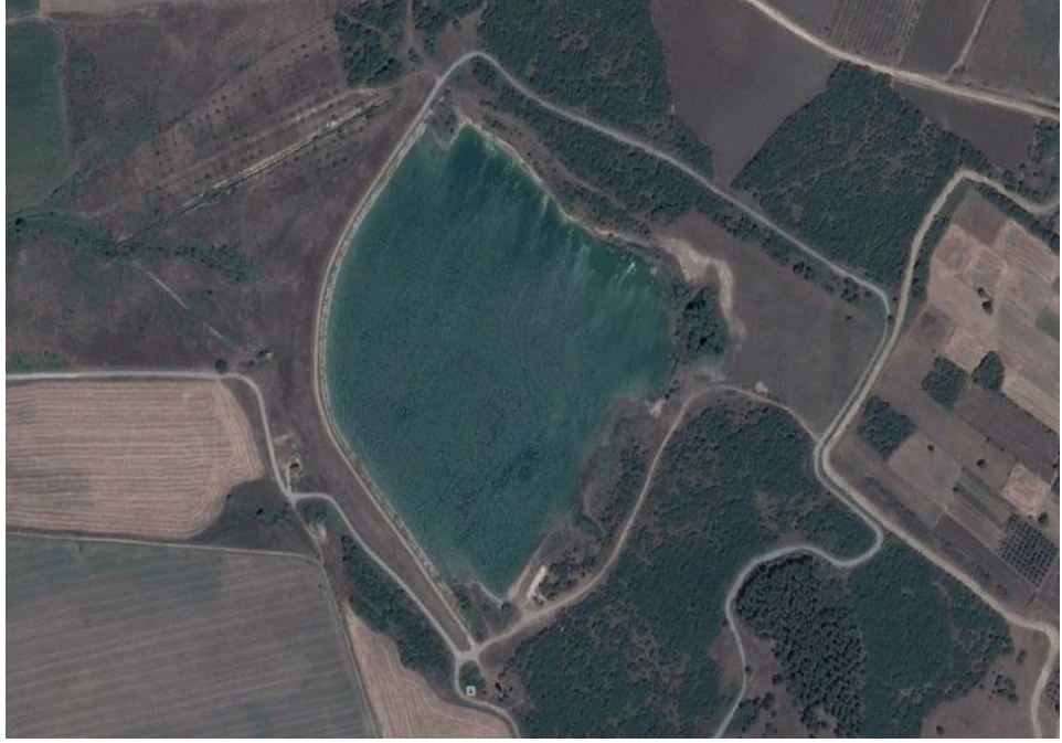
Şekil 3.4. Yolçatı (Göbelye) Göleti'nin üstten görünümü
