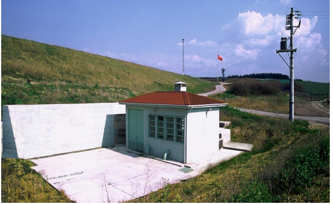
Şekil 3.3. U.Ü. Tarımsal Uygulama ve Araştırma Merkezi istek yöntemi ile işletilen basınçlı sulama sistemine ait pompa istasyonu
