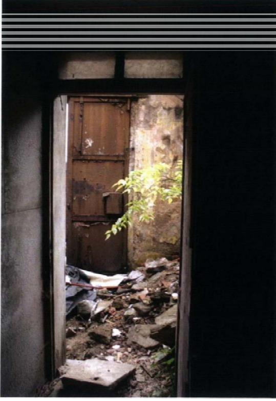
Şekil 30: Surp Asdvadzadzin Kilisesi'nin kuzeybatı köşesinde bulunan yapıların görünüşü.
