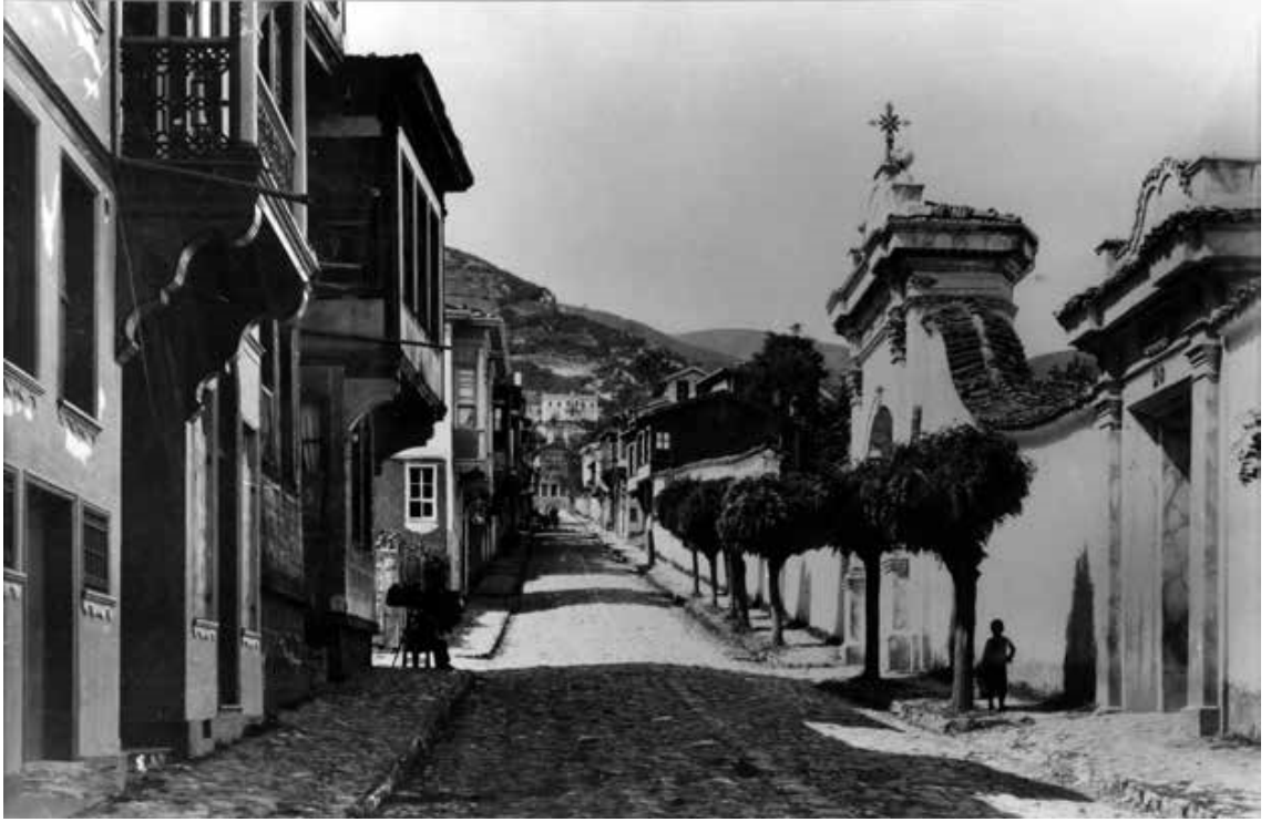
Şekil 24: Surp Asdvadzadzin Kilisesi avlu kapılarının güneybatıdan görünüşü (1904, http://img.xooimage.com/files99/c/5/f/ermeni-mahallesi-kilisesi-3ff1c7d.jpg ).
