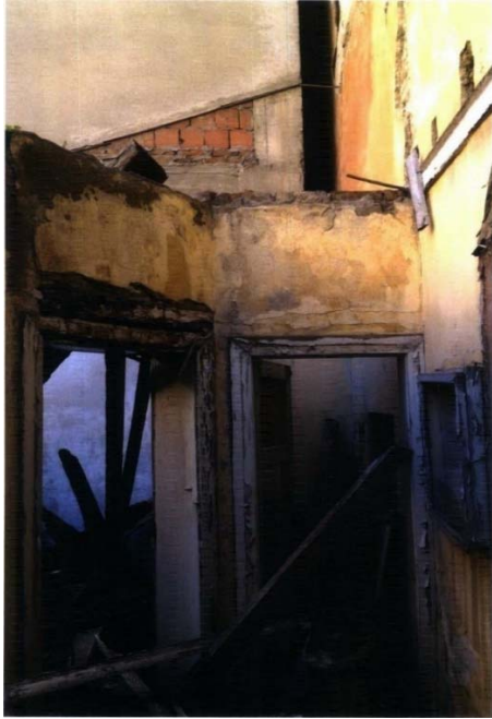
Şekil 27: Surp Asdvadzadzin Kilisesi avlusunun güneybatı köşesinde bulunan yapıların görünüşü.
