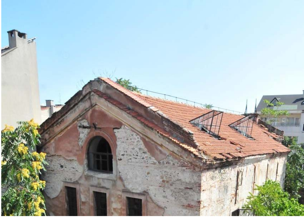
Şekil 36: Surp Asdvadzadzin Kilisesi çatının güneybatıdan görünüşü.
