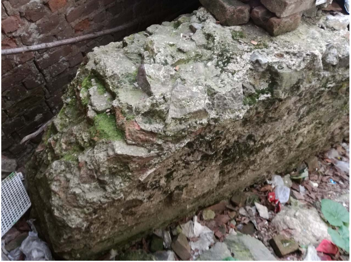
Şekil 50: Çengiler Surp Anardzad Kilisesi'nin günümüze ulaşan duvar kalıntısı.
