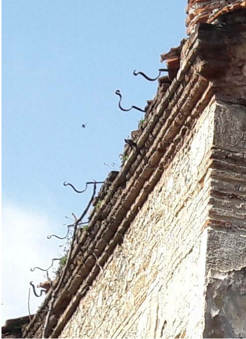
Şekil 38: Surp Asdvadzadzin Kilisesi güney duvarı korniş.
