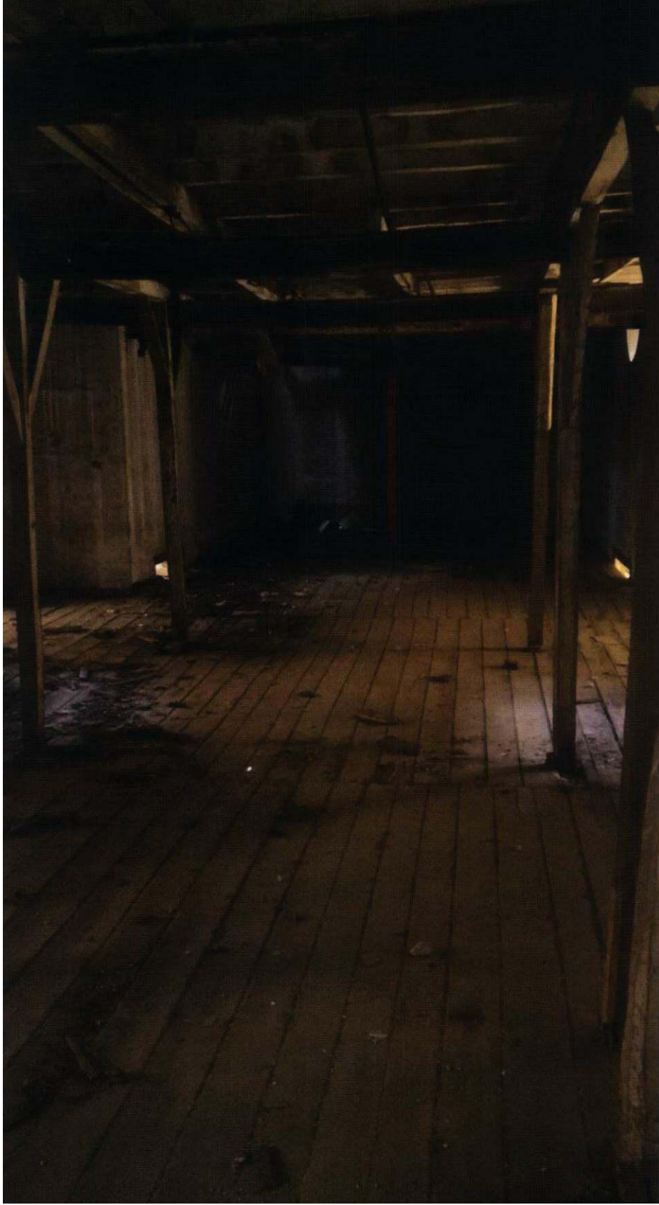
Şekil 22: Surp Asdvadzadzin Kilisesi ikinci kat döşemesi tavanı.
