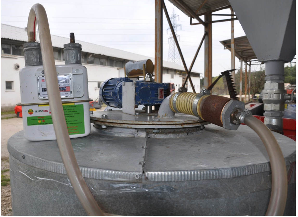
Şekil 3.11. Fermantör gaz çıkış borusu ve sayaç bağlantısı
