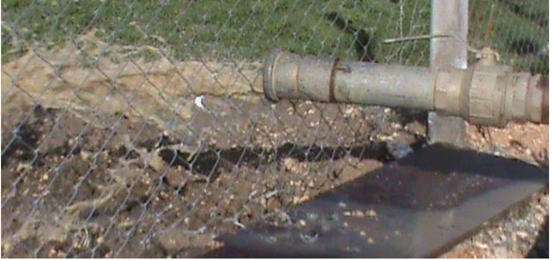
Şekil 4.14. (a) Kolon borusunun ve hava borusunun kuyuya girişi (b) Çıkan çamurlu suyun dışarı verilmesi
