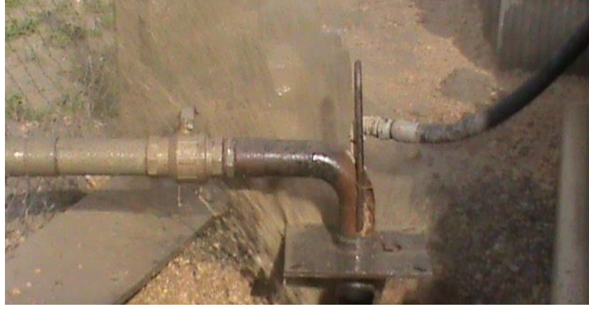
Şekil 4.16. İnkişaf sırasında vana kapalı durumda iken sondaj borusundan basınçlı su çıkışı
