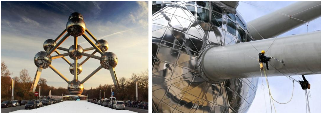
Şekil 3.5. Brüksel'de bulunan Atomium binası ( http://atomium.be/#/Photos.aspx , 2012)
