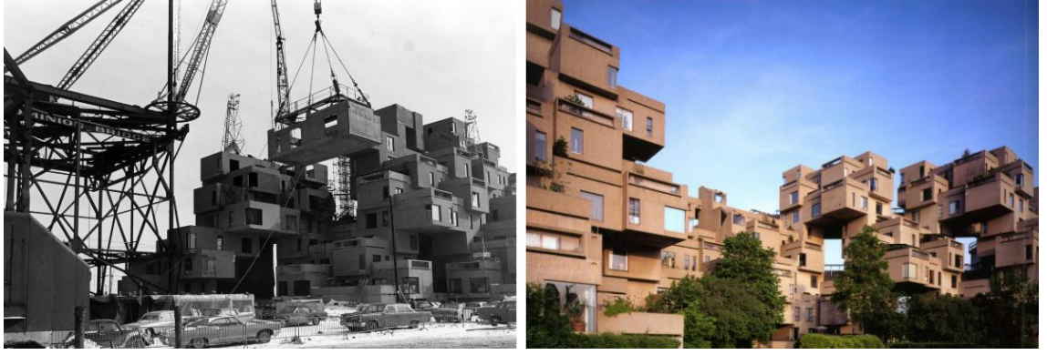
Şekil 3.15. Moshe Safdie'nin tasarladığı Kanada'daki Habitat 67 projesi ( http://www.msafdie.com/#/projects/habitat67 , 2012)
