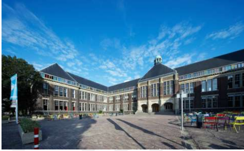
Şekil 2.82. Delft Teknoloji Üniversitesi Mimarlık Fakültesi Binası (Perez 2018a)
