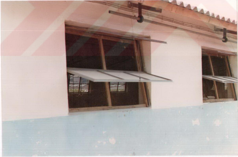
Şekil 4.2. Mekanik Açma Kapama Mekanizmasına Sahip Bir Kümestin Dıştan Görünüşü
