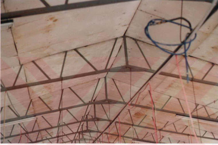
Şekil 4.3. Çatı Yalıtımında Strofor Kullanılmış Bir Kümes
