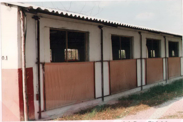
Şekil 4.1. Branda Örtü İle Örtülmüş Kümeste Pencereilerin Dıştan Görünüşü
