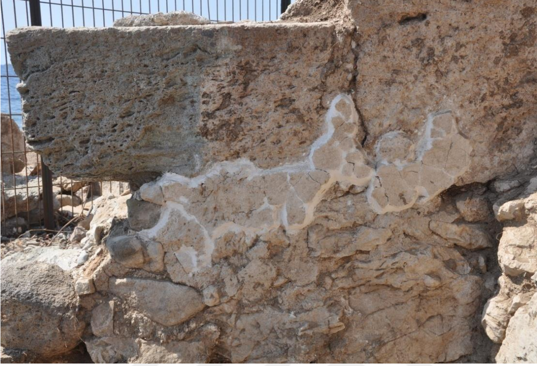
A) LA-1 Güneybatı Duvardaki Sıva. Restorasyondan Sonra
