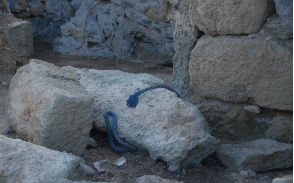
B) 2013 Gemi Halatının Bağlanması Sonucu Hasar Verilen Kapı Kolonları
