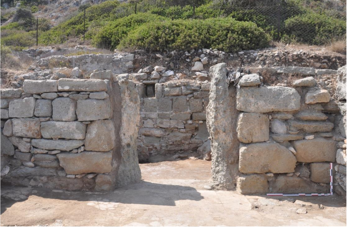
A) Restorasyondan Sonra Ön Oda Duvarları – I
