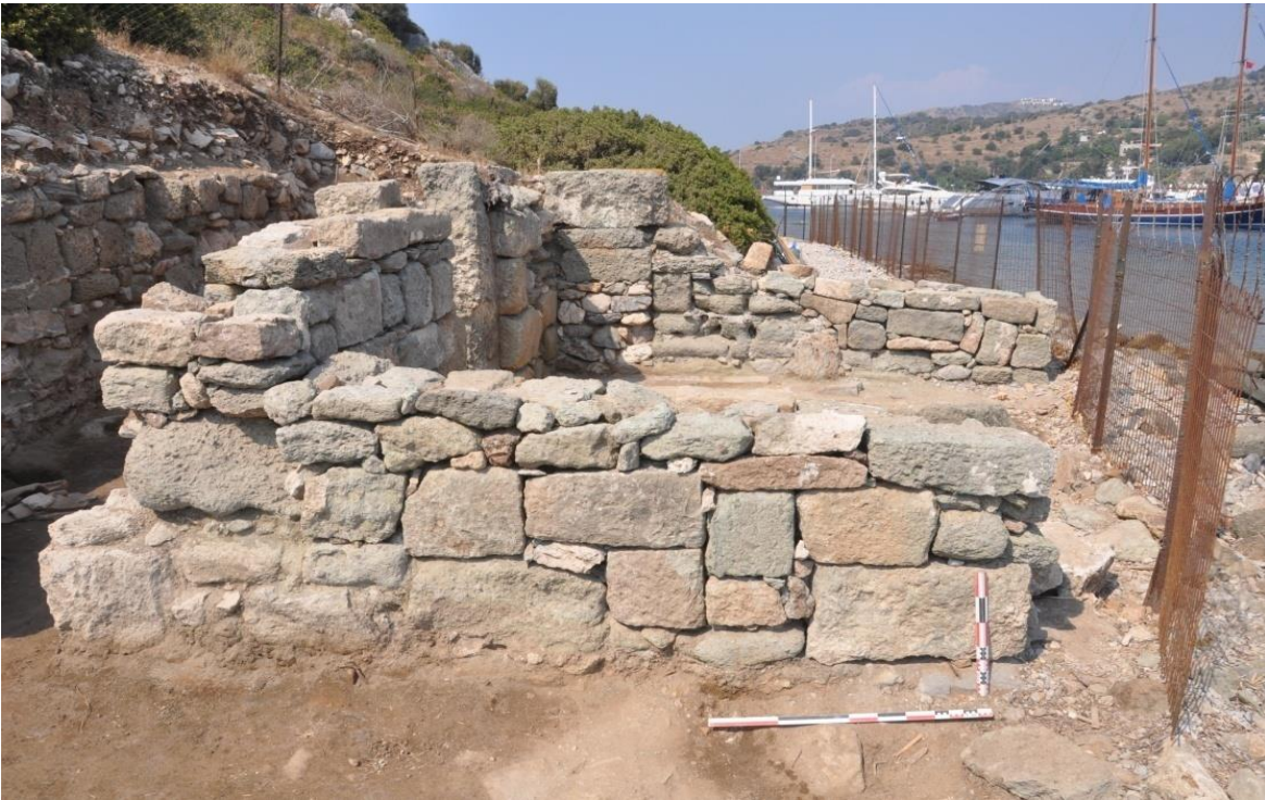
B) Restorasyondan Sonra Ön Oda Duvarları – II
