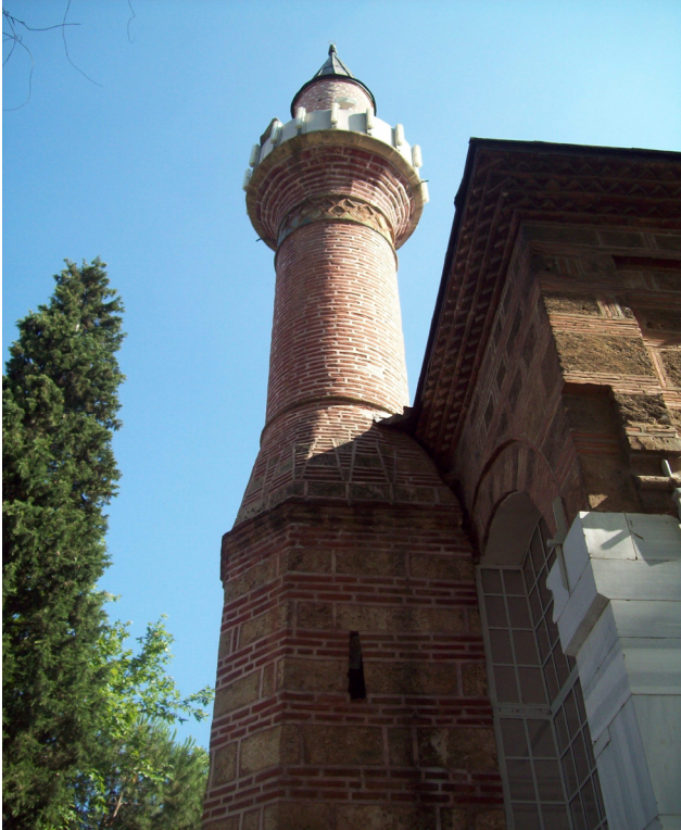
Hamzabey Camii'nin minaresi
